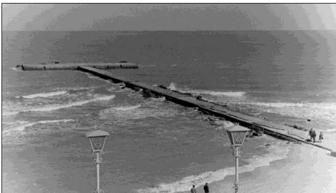
Рис. 3. Внешний вид Т-образной буны на западном берегу Черного моря в Румынии, в условиях умеренно-отмелого подводного склона и насыщенного вдольберегового потока наносов (фото Ю. Д. Шуйского)
