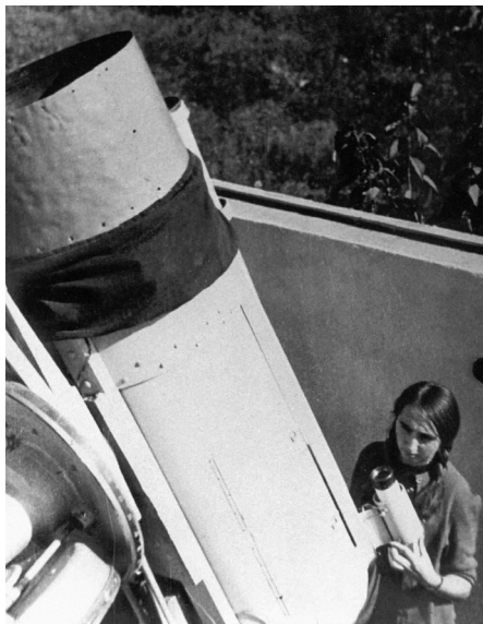
А. В. Драгунова у катадиоптрического телескопа системы П. П. Аргунова с диаметром зеркала 17 дюймов. 1968 г.
