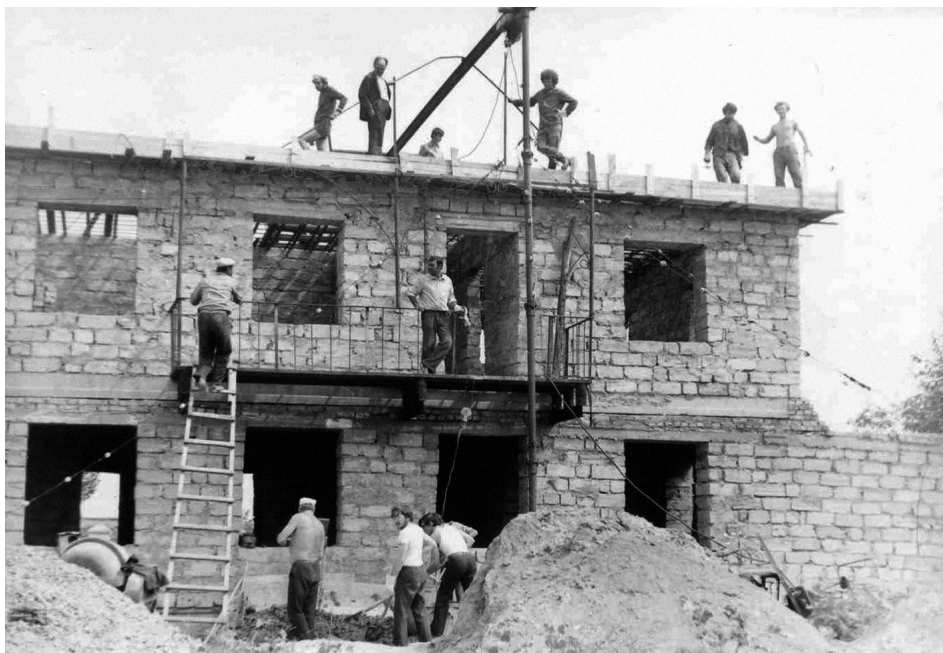
Строительство двухэтажного жилого дома для сотрудников станции в с. Маяки. Наверху, второй слева — В. П. Цесевич. Около 1980 г.
