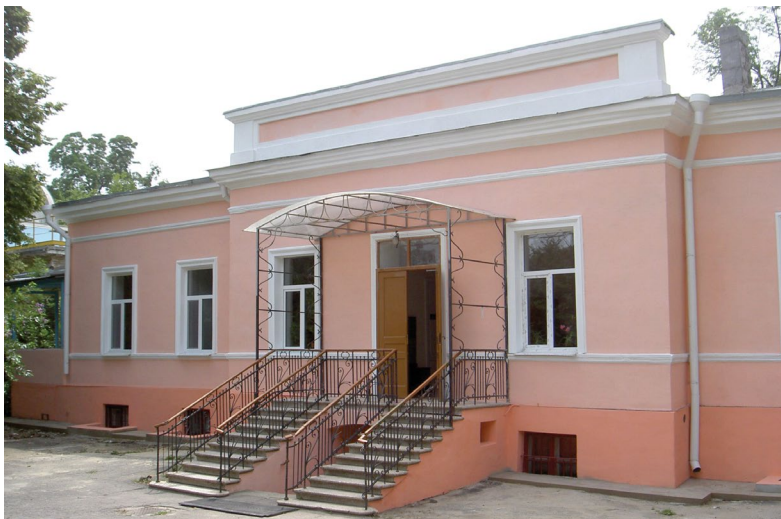
Отремонтированный фасад здания обсерватории. 2011 г.
