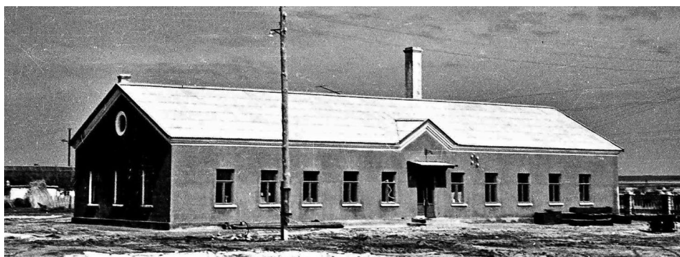
Вид главного здания наблюдательной станции в с. Маяки после окончания строительства. 1956 г.
