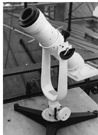
Астрономическая трубка АТ-1, созданная в СССР для первых наблюдений искусственных спутников Земли
