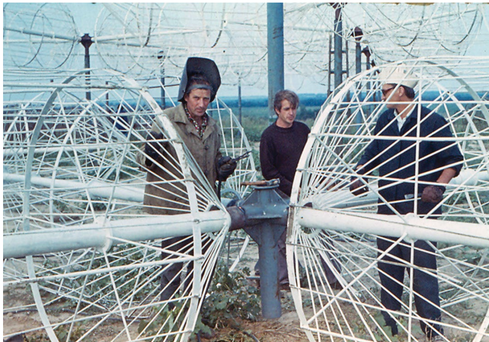
Строительство радиотелескопа УРАН-4 в с. Маяки. 1970-е гг.
