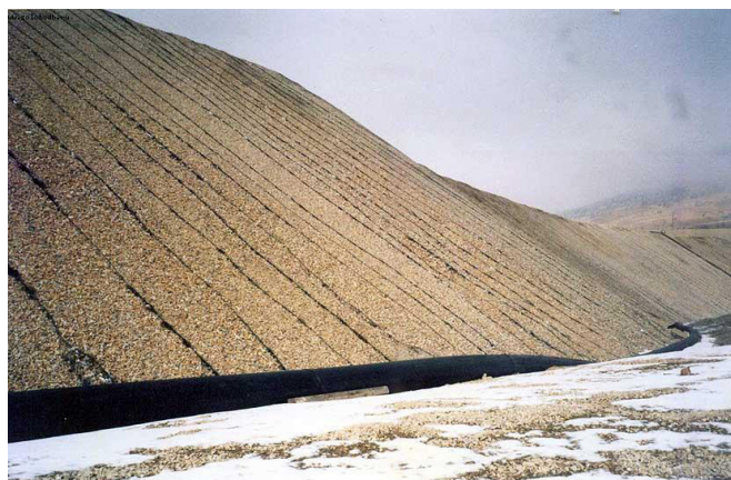
Рис. 2. Кучное бактериальное выщелачивание меди из некондиционных руд медного рудника Bingham Canyon (штат Юта, США)
