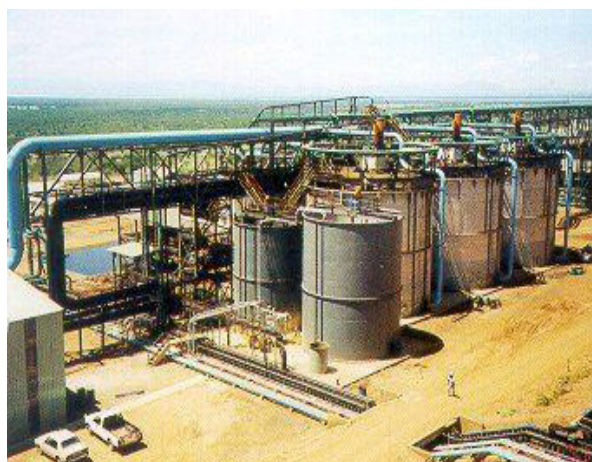
Рис. 1. Чановая установка биоокисления для предобработки золотоносных минералов рудника Fairview (Южная Африка)
