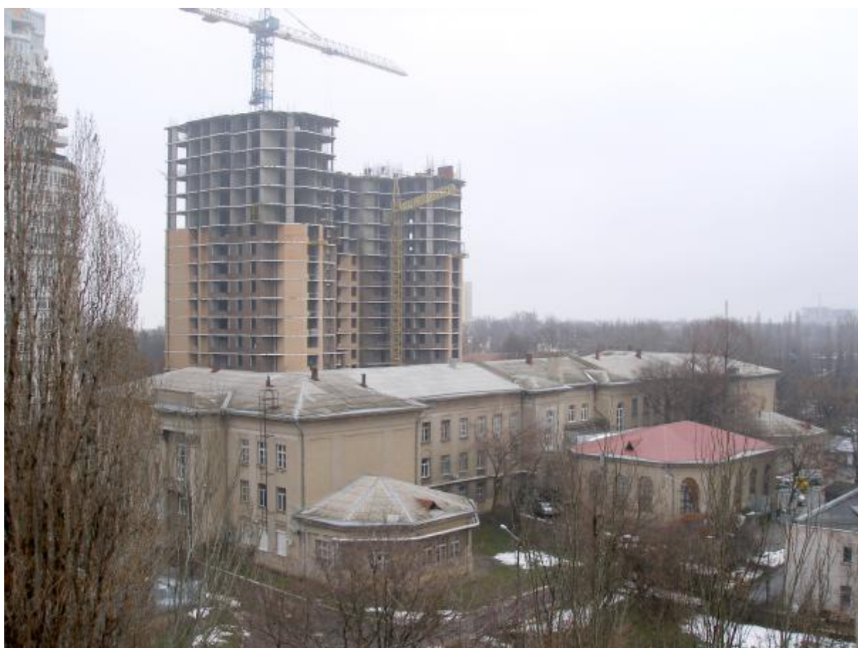
Здание биологического факультета в окружении строящихся высотных домов. 2015 г.
