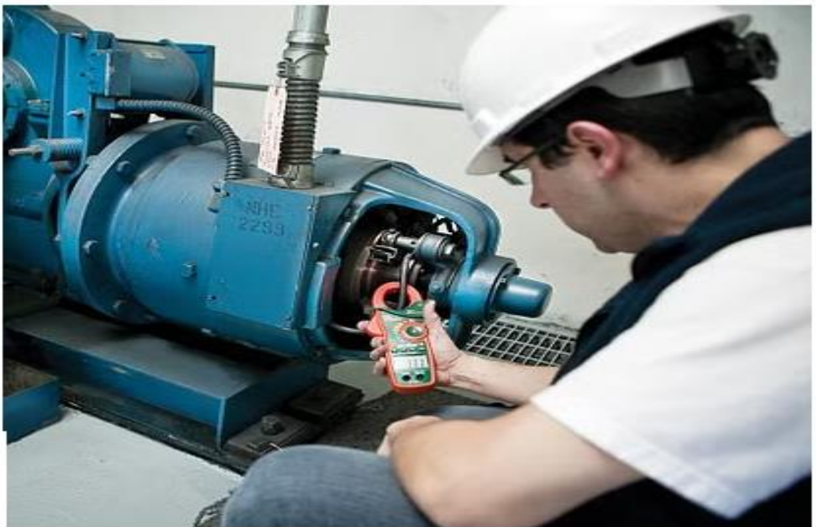
Рисунок 3.2 - Забір опору ізоляції двигуна
