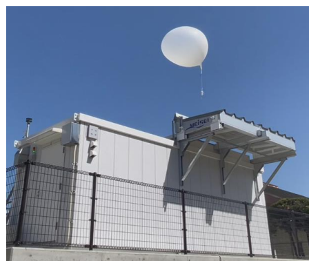
Автоматична пускова установка зонду
