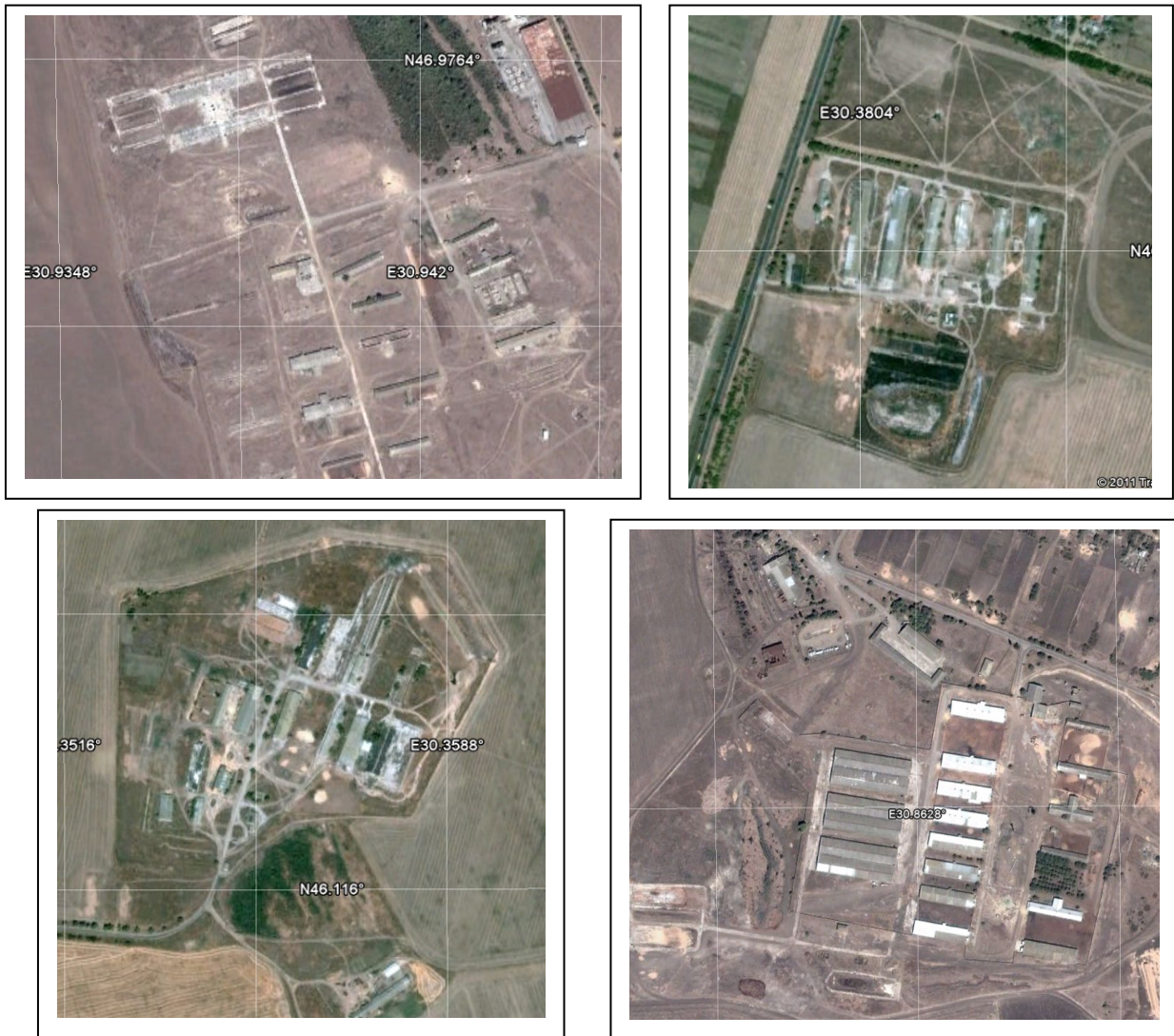
Рис. Б4. Тваринницькі ферми та комплекси (невеликі за розміром ділянки із розрідженою забудовою, будівлі зазвичай мають подовжену форму, іноді розрізняються загони для тварин і інші допоміжні будівлі)
