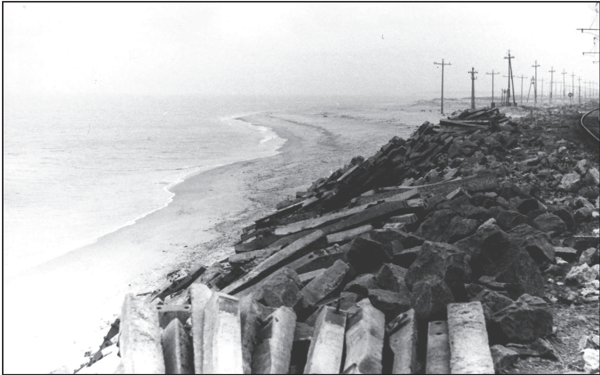
Рис. 2. Каменная наброска и шпалы не смогли защитить железнодорожное полотно от волнового размыва и штормового приюба на Днестровской пересыпи, 1982 год (фото Ю. Д. Шуйского)
