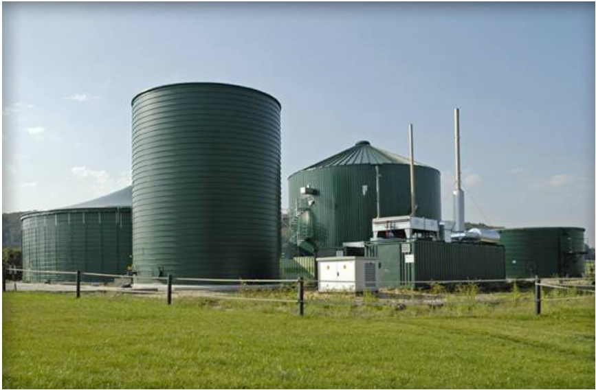
Рис. 12. Біореактори для біологічного очищення СВ (метантенки)
