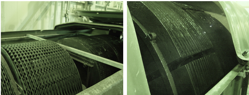
Рис. 22. Зовнішній вигляд дискових біофільтрів [Серебряков Д.В., Морозов В.В., 2008]
