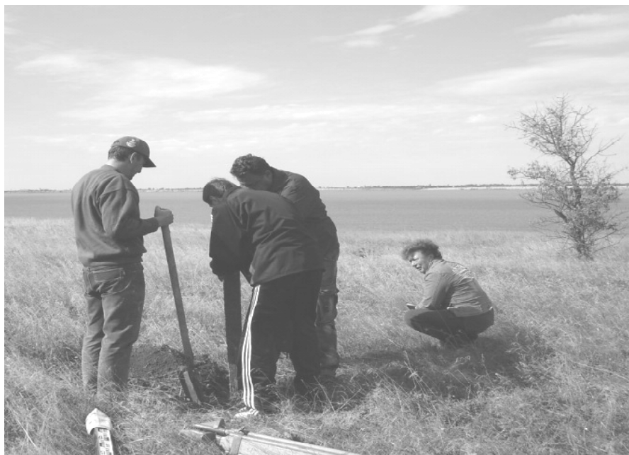
Рис. 6. Сотрудники ОНУ устанавливают наблюдательный бетонный репер на берегу лимана Бурнас (побережье Черного моря).
