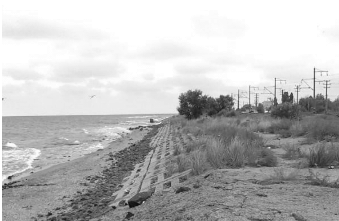
Рис. 4. Искусственная терраса защищает железную дорогу от разрушения. В контроле за состоянием берега принимают участие студенты-географы ОНУ.
